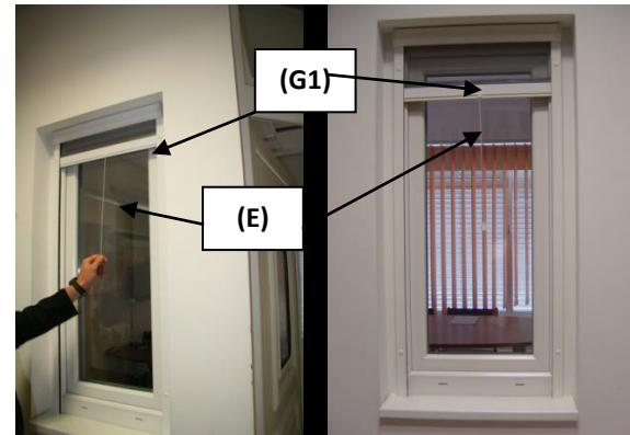
Dvig: **POMEMBNO!** z **obema rokama** primite zaključno letev (G2). Z rahlim potiskom navzdol se mehanizem sprosti in rolo se začne navijati. Pri tem je potrebno rolo zadrževati, dokler le-ta ni dokončno navit. Če se samostojno ne navije do konca v kaseto, je potrebno z rahlim ročnim potiskom navzgor rolo potisniti do konca v kaseto.
