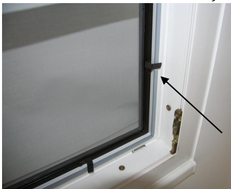
MONTAŽA – POGLED OD ZNOTRAJ
